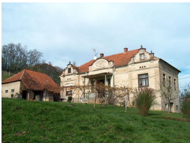
Sl.27. Kapelščak, kbr. 12 urbana «gradska» kuća
